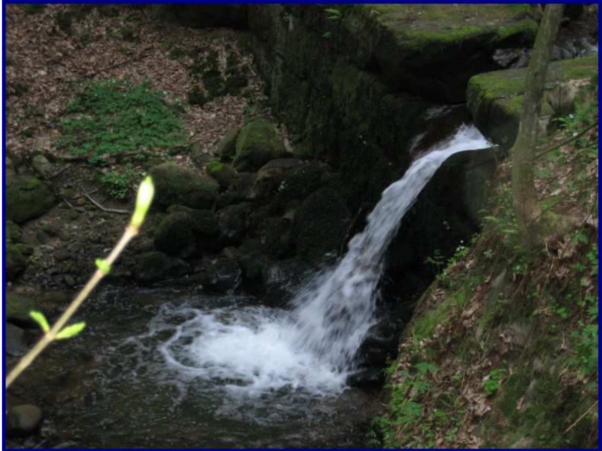
Abbildung 6: Wehr der ehemaligen Kohlmühle
